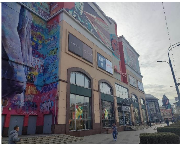
Фотография 4. Фасад здания
