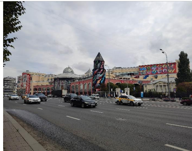
Фотография 9. Подъездные пути и фасад здания
