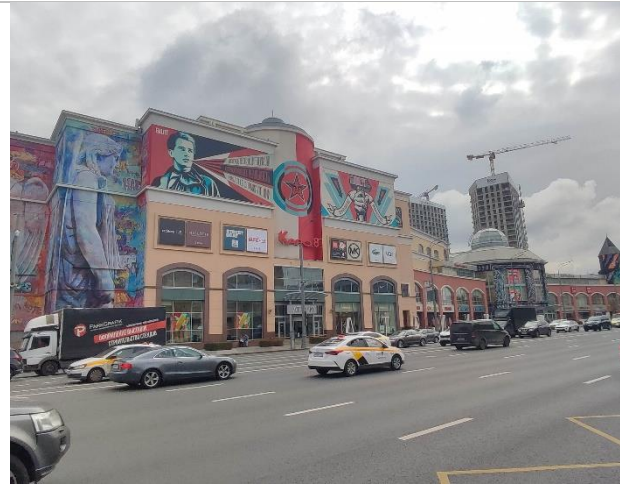
Фотография 8. Подъездные пути и фасад здания
