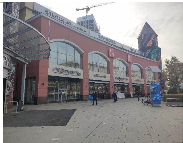
Фотография 5. Фасад здания
